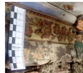
Gebäudekern von ca. 1570: Balken im Fischerhaus
