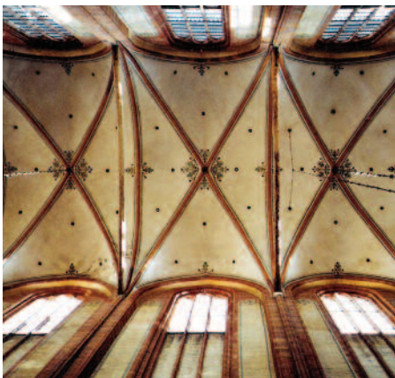
Mittelschiffgewölbe St. Nikolai
